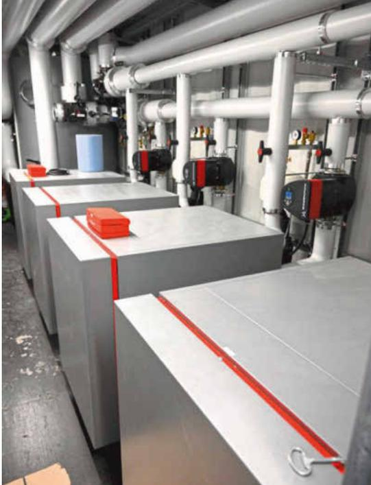
Vier separat zuschaltbare Wärmepumpen nutzen Umgebungswärme aus dem Erdreich, nämlich aus dem Grundwasser, für die Energiegewinnung. (Foto: M. Rehm)
